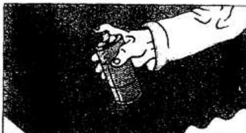
Рис. 14. Окраска срезов, сколов и повреждений защитного слоя
